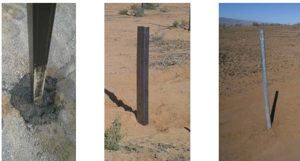
Ilustración 4: Ejemplos de hincado
