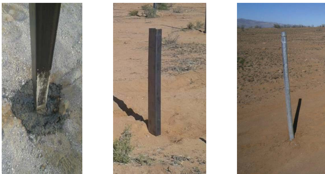
Ilustración 4: Ejemplos de hincado
