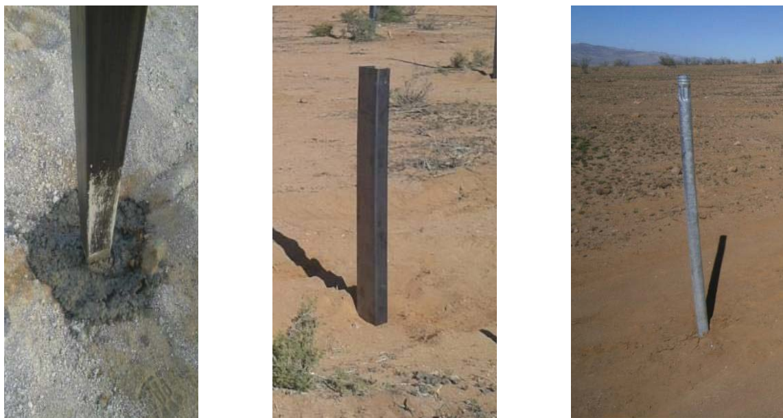
Ilustración 5: Ejemplos de hincado
